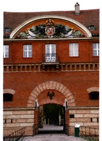
Einer der Eingänge zur Zitadelle in Berlin-Spandau.
